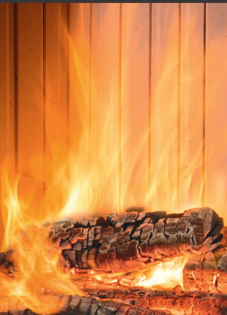
Revêtement du foyer en chamotte
